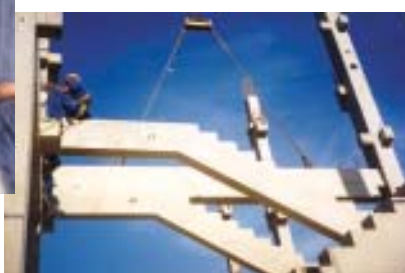
• Montagem das escadas
