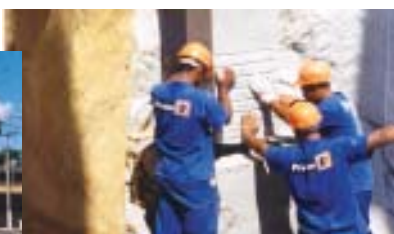
• Montagem do primeiro pilar
