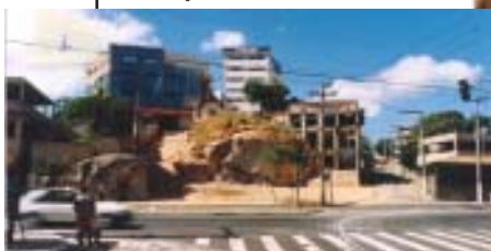
• Terreno da Faesa antes do início das obras
