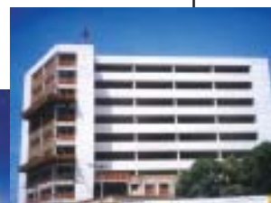
• Fase atual da obra, montada em 120 dias
