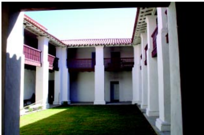
A RESIDÊNCIA ANEXA TEVE SUA CONFIGURAÇÃO ORIGINAL RESGATADA COM RETIRADA DE MURETAS QUE CERCAVAM O CENTRO DO PÁTIO E COM REPLANTIO DA GRAMA
